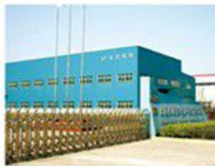
上海凡清环境工程有限公司厂房项目 Shanghai Fanqing Environmental Engineering Co.Ltd
