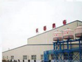
长春奥奇汽车涂装厂 Changshen AnQi Coating Corp.
