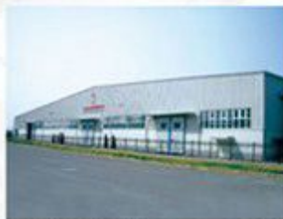
大连达家家具有限公司新建厂房 Dalian Matt Furniture & Components
