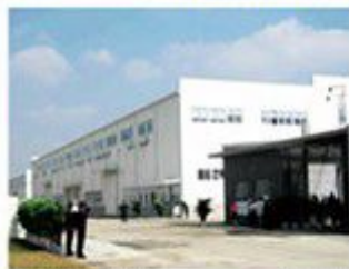
昆山华风风电科技有限公司厂房 Kanshan Huafeng Wind Power Technology Co.Ltd.
