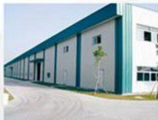
广州美穗钢结构有限公司厂房 Guangzhou Maizui Steel Structure Co. Ltd.
