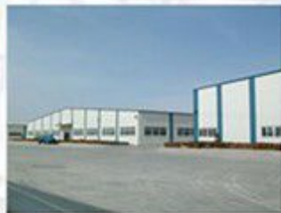
大连实德化学建材工业园厂房建设 Dalian Shide Group
