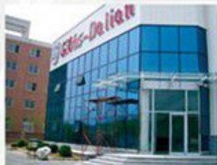
吉普斯(大连)铸造有限公司新建厂房 Gibbs-Delian Die Casting Corp.
