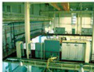
吉布新(大连)铸造有限公司新建厂房 Gibbs-Dalton Die Casting Corp.
